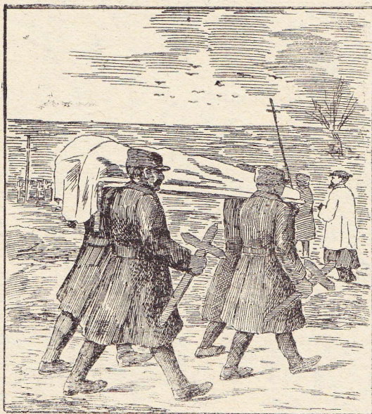
Begravenis achter het front.
